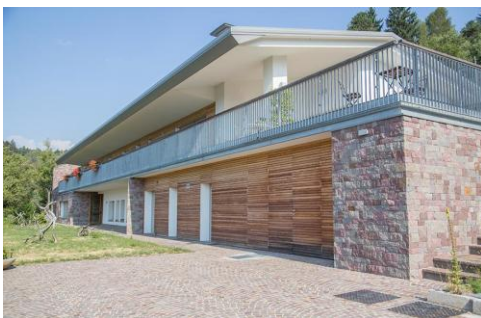
Ristrutturazione e ampliamento chiavi in mano - Civezzano (TN)
