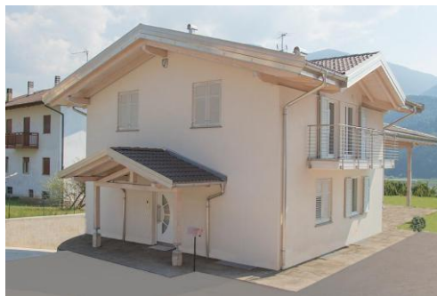
Costruzione casa privata civile abitazione - Canale di Pergine (TN)
