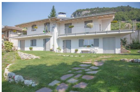
Costruzione casa bifamiliare civile abitazione - Tavernaro (TN)
