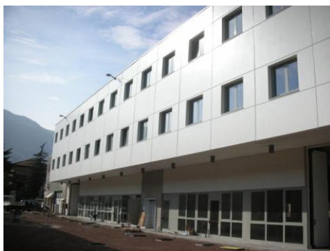
Capannone commerciale uffici e appartamenti
